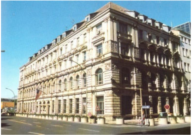
Ehemalige Botschaft der USA in der Neustädtischen Kirchstraße 4/5, Mitte; heute steht ihr Neubau wieder am ursprünglichen Ort (Palais Blücher), Pariser Platz, direkt neben dem Brandenburger Tor. Foto: Presse- und Informationsamt der Bundesregierung, Bundesbildstelle
